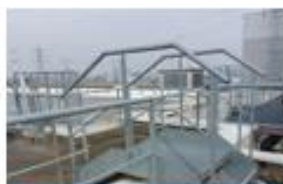
Passerelle technique métallique galvanisée
